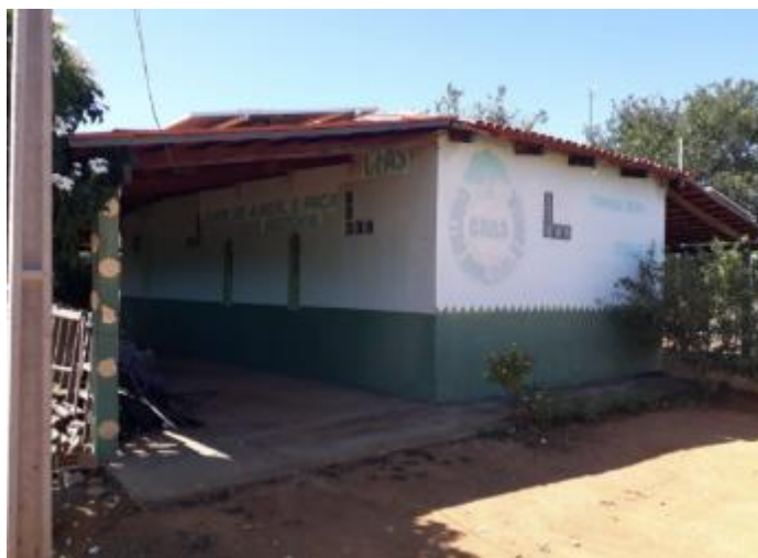
Figura 4 – Parte da Área Edificada do CEAS
