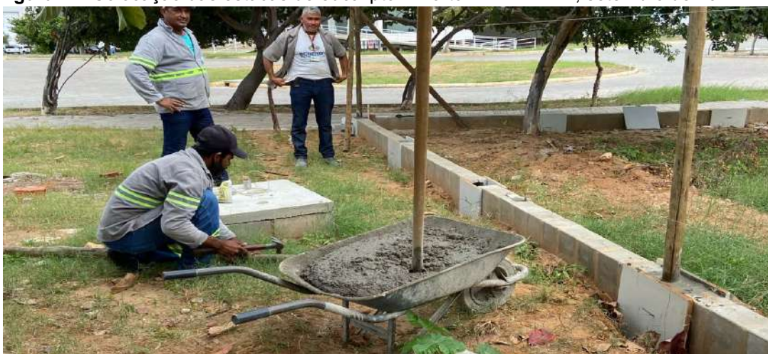
Figura 4 – Colocação das estacas de eucalipto – Horto FARMAVIVA , setembro de 2022.
