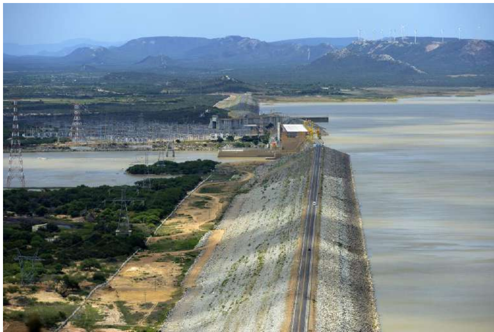
Figura 020 – Barragem de Sobradinho em 2022.
