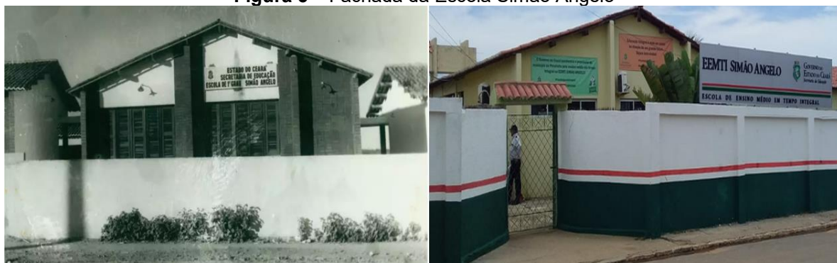
Figura 5 – Fachada da Escola Simão Ângelo
