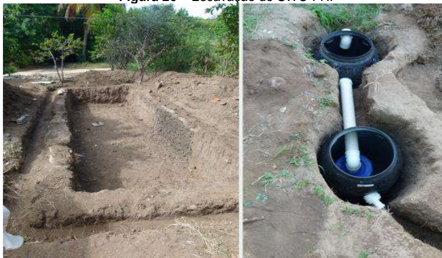
Figura 26 – Escavação do SWC-FH.
