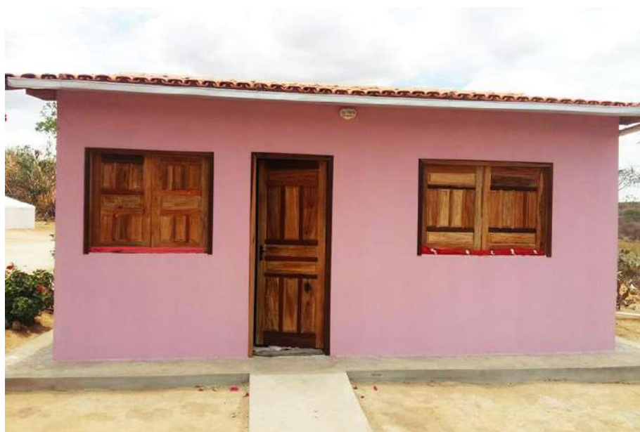
Figura 8 - Fachada de uma moradia do PNHR no semiárido nordestino.
