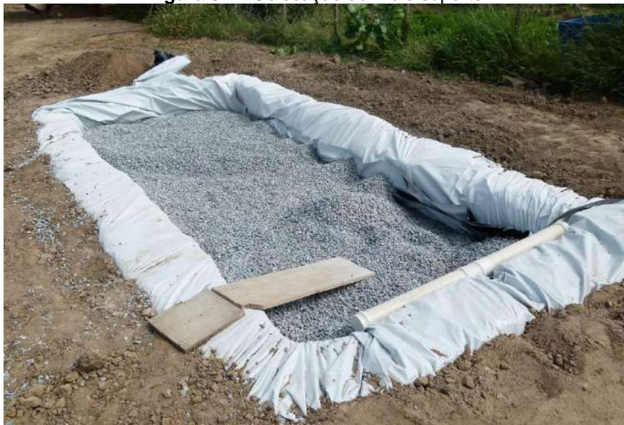
Figura 37 – Colocação do meio suporte.
