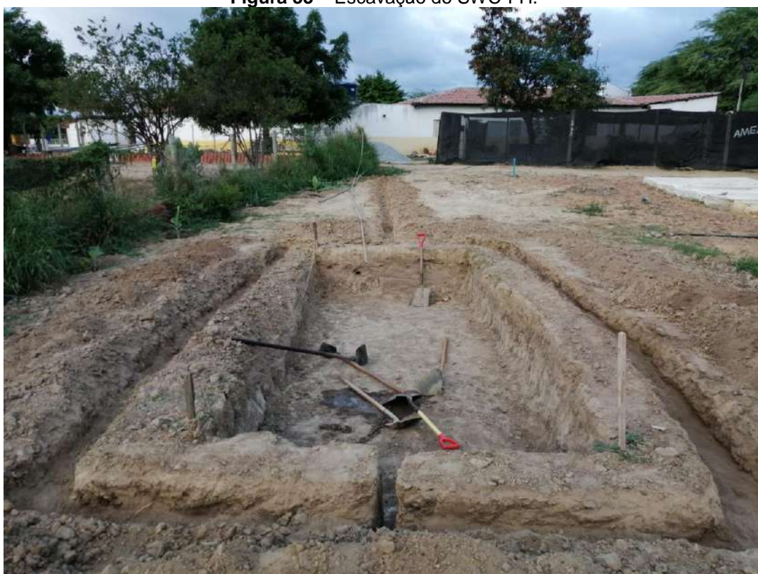
Figura 33 – Escavação do SWC-FH.
