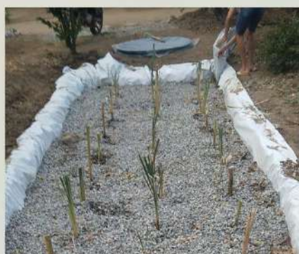
COLOCAÇÃO DAS MACRÓFITAS PASSO 11
