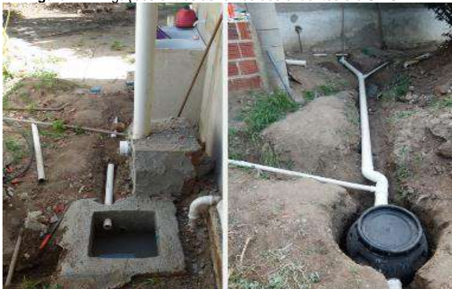
Figura 27 – Ligações entre as fontes dos efluentes e o SWC-FH.
