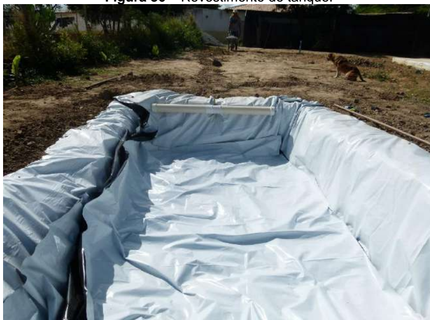
Figura 36 – Revestimento do tanque.
