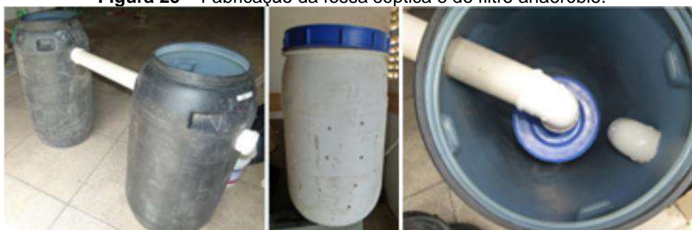
Figura 25 – Fabricação da fossa séptica e do filtro anaeróbio.
