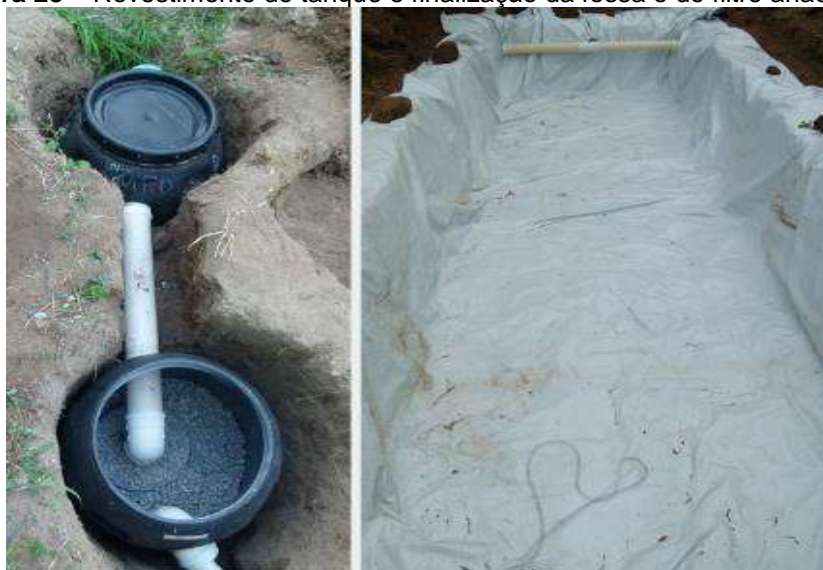
Figura 28 – Revestimento do tanque e finalização da fossa e do filtro anaeróbico.
