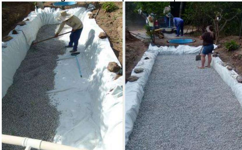
Figura 29 – Colocação do meio suporte.
